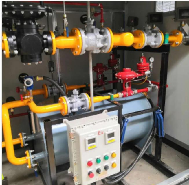
双气化双调压撬装设备，包括气化器、第二气化器、气管、压力调节箱与加热器，该双气化双调压撬装设备，设置有支台机构，支台机构包括有支座、直杆与绕旋套筒等，通过设置的绕带杆、绕旋套筒以及第二绕旋套筒的配合使用可以将本卷起的绕带杆展放开，将绕带杆上的两组挂环分别与直杆以及第二直杆上的挂钩连接，使得加热器以及压力调节箱的上方能够多一层保护装置，可以一定程度的防雨、防风以及防落石，可以一定程度上降低设备受自然环境影响的程度。该双气化双调压撬装设备，设置有控制面板与置纳槽，置纳槽为控制面板提供收纳空间，通过设置的绕旋板配合滚动槽的使用可以使得控制面板能够在置纳槽的内部前后改变位置，通过设置的封挡板、收板槽与磁力槽的配合使用可以使得控制面板能够处于一个密闭空间内，而且该密闭空间是可以打开的，可以使得控制面板上的控制按钮以及控制面板内部的控制元件均可以得到保护。调压箱由阀门、压力表、过滤器、调压器、流量计及安全附件组装而成。威县专业调压箱售价
