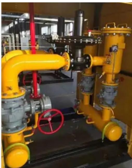
天然气调压撬装主要适用于天然气长输管线的分办理站，用于首站的下游或城市中压管网的的上游，作为城市门站、燃气管网配气站[CNG站等，高压、高-中压燃气管网的调压和稳定。具有净化、计量、调压、分配、安全保护等功能。特点：1、可无人值守，只需定期检；2、每一调压支路采用100%流量设计，主副路自动切换，保障不间断供气；3、设备出厂前各参数可按用户要求设置；4、结构合理、功能完善、可靠性高、系统协调性好；5、结构紧凑，造型美观，占地面积及所要求的安全距离小。适合户内外安装；6、安装，调试简单，使用，维护方便；7、箱体材料采用冷轧，外表面采用防紫外线喷塑处理，防腐防晒能力强；8、安全保障：配置有安全切断阀、安全放散阀，确保下游压力因故超高时迅速加以控制或截流。调压站内配备超高压自动切断装置、安全放散装置，确保在用气量和进口压力发生波动时，自动将出口压力值保持在一定的范围内[CNG减压撬配备一、二级换热器，确保设备在饱满状态下运行，同时确保设备严冬正常运行；调压站具有多点连锁控制、流量计量、远传显示、自动加臭、自动报警、保温等功能；设备采用撬装结构，设计合理、紧凑，安装工艺简单，操作方便。
